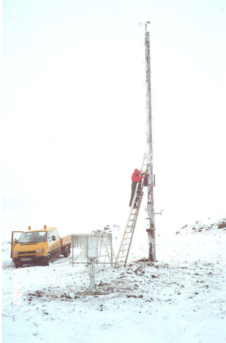
Mynd 1. Sjálfvirk veðurstöð Veðurstofunnar í Hellisskarði. Ljós. Þórður Arason, janúar 2001.
