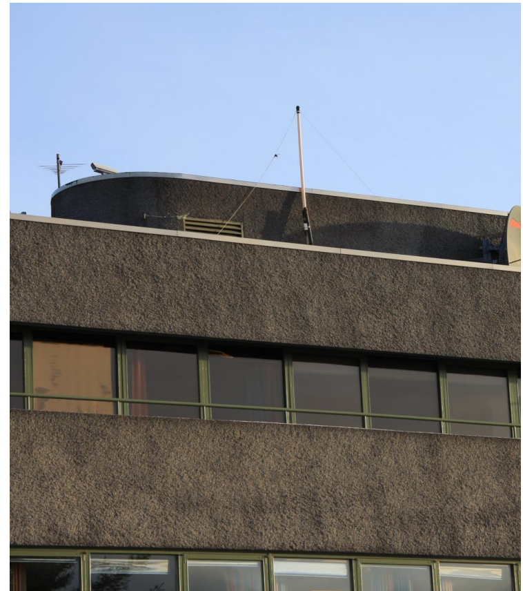
WWLLN loftnet á þaki Veðurstofuhúss í Reykjavík. Ljósmynd. ÞA 9. febrúar 2016.
